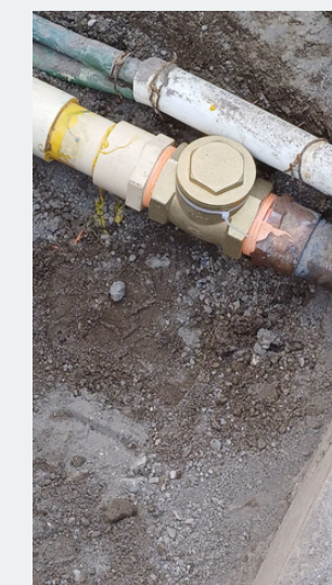
Reparación de tubo de agua que suministra el edificio A
