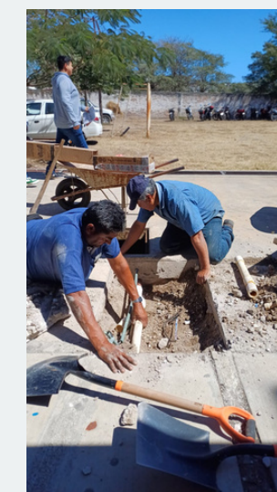
Reparación de tubo de agua que suministra el edificio A
